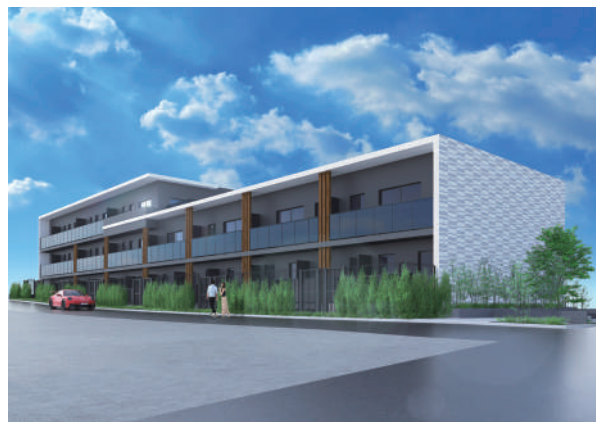
設置マンションの外観イメージ
