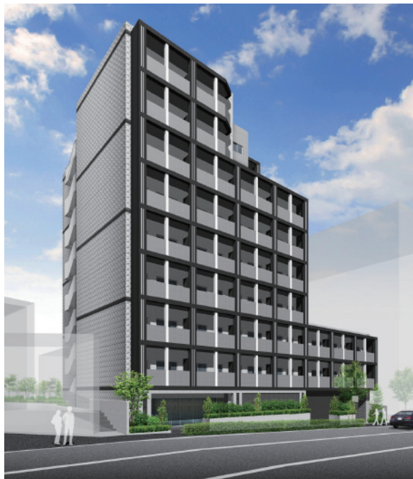
ステージグランデとさわ台アジュールコート 外観
